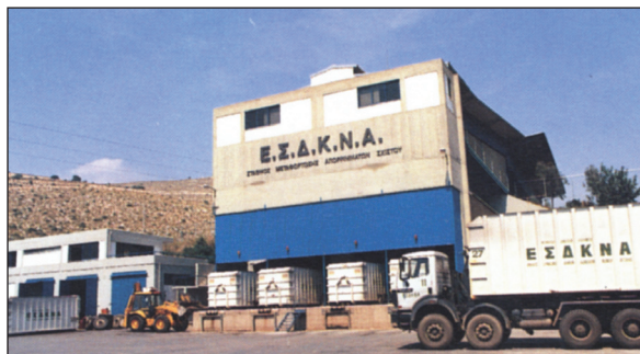
Σταθμός μεταφόρτωσης απορριμμάτων Σχιστού
