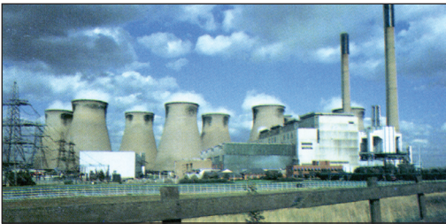
Εργοστάσιο παραγωγής ηλεκτρικής ενέργειας.
