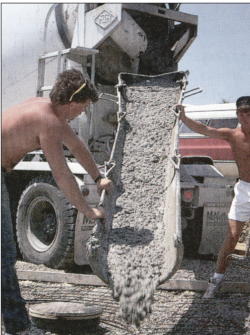
Χρήση τσιμέντου σε κατασκευαστικά έργα.
